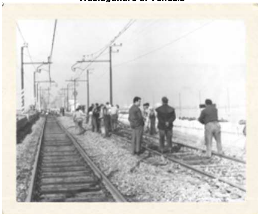
Livellamento binari sul ponte Traslagunare di Venezia
