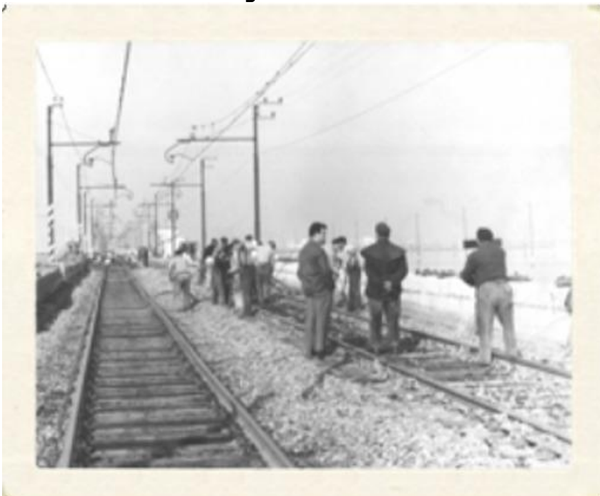
Livellamento binari sul ponte Traslagunare di Venezia
