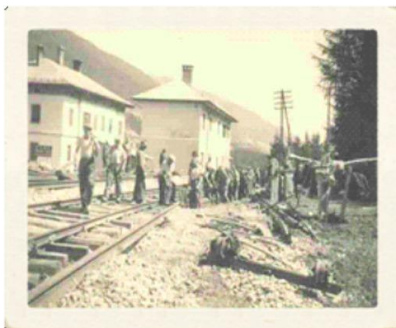
Sostituzione rotaie in linea
